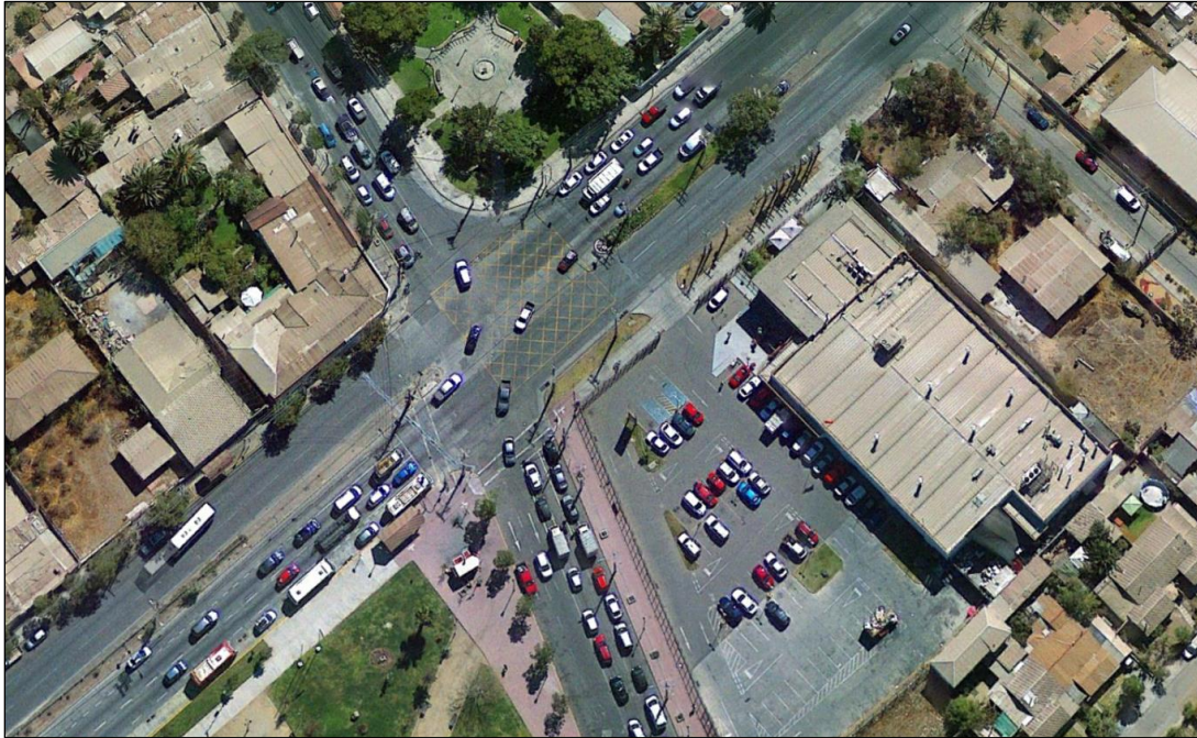
FIGURA 4-20: Intersección Camino Melipilla con José Luis Caro – Avenida Los Silos.
