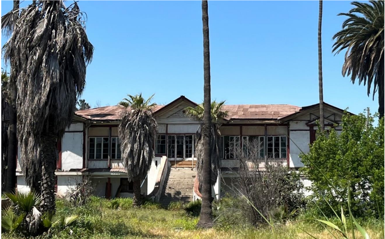
FIGURA 2-5: Fachada Casona Ex Fundo Santa Rosa 2023.
