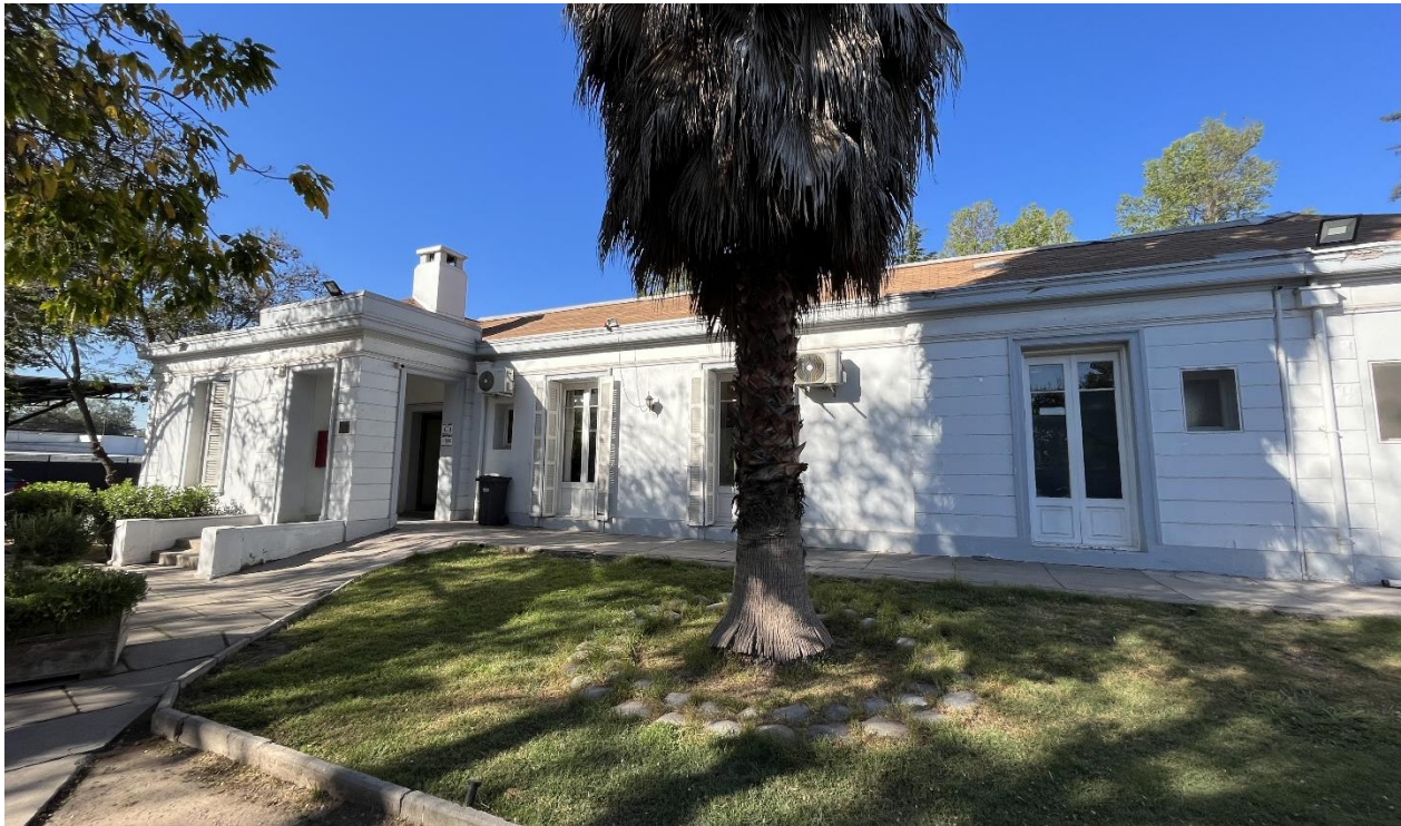
FIGURA 2-19: Edificio Consistorial Municipalidad de Padre Hurtado.
