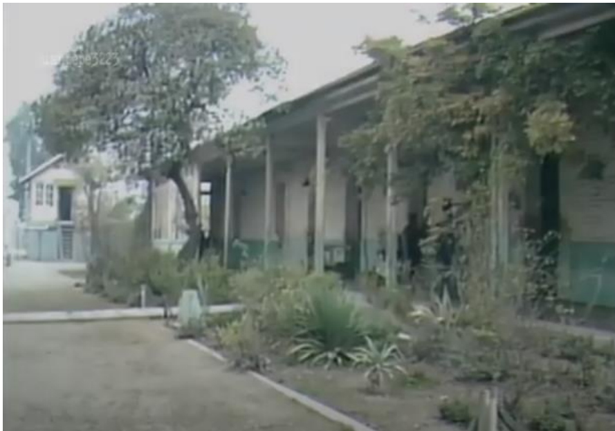
FIGURA 2-10: Antigua Estación Marruecos (Estación Padre Hurtado), 1989.
