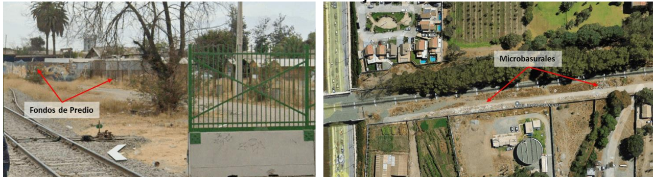
FIGURA 7-41 Estado Actual terrenos adyacentes a la Línea Férrea.
